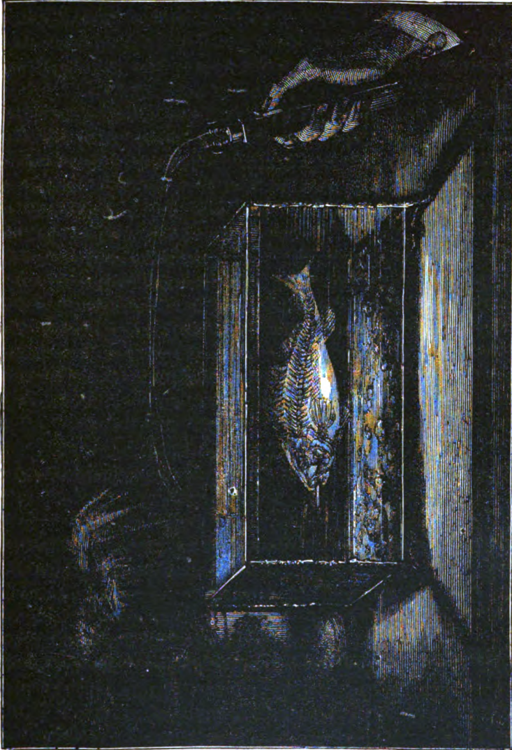
Fig. 172. — Poissons lumineux. Expérience imaginée par M. G. Trouvé pour démontrer l'innocuité de la chaleur de ses polyscopes électriques à fil de platine ou à lampe à incandescence.
