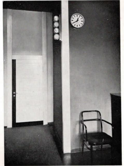
Abb. 8. „Fuld“-Lichtrufarmatur und Normalzeit-Nebenuhr in einem Büro der „Dewog“ Deutsche Wohnungsfürsorge A. G. für Beamte, Angestellte und Arbeiter, Zweigstelle Breslau.
