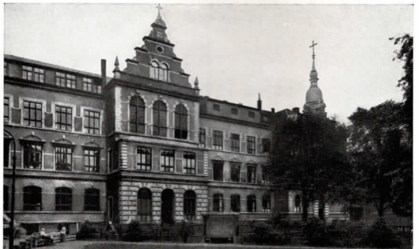
Abb. 98. Die Diakonen-Anstalt in Duisburg besitzt eine Fuld-Glühlampenzentrale für 4 Amtsleitungen und 40 Nebenstellen und eine vollautomatische Zentrale für den internen Verkehr.
