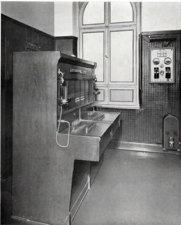
Abb. 55. Fuld-Glühlampenzentrale für 5 Amtsleitungen und 30 Nebenstellen in der Dresdner Bank Filiale Gladbach-Rheydt.
