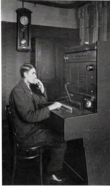
Abb. 22. Halbautomatische Fuld-Fernsprechzentrale für 10 Amtsleitungen und 100 Nebenstellen sowie Normalzeit-Signal-Hauptuhr in den Klöckner-Werken A. G., Abt. Eisen- und Drahtindustrie, Düsseldorf.
