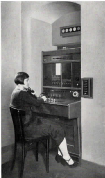
Abb. 29. Der Arbeitgeberverband für den Bezirk der nordwestl. Gruppe des Vereins deutscher Eisen- u. Stahl-Industrieller in Düsseldorf verfügt über eine Fuld-Fernsprechanlage, bestehend aus einer Glühlampenzentrale für 6 Amtsleitungen und 30 Nebenstellen, einer vollautomat. Zentrale für 35 Teilnehmer für den Hausverkehr, ferner eine Personen-Lichtrufanlage.
