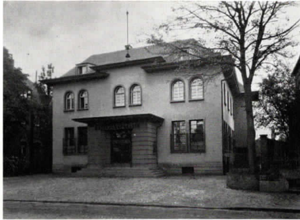
Abb. 25. Die Allgemeine Ortskrankenkasse in Hermülheim b. Köln a. Rh. besitzt eine Fuld-Fernsprech-Reihen-anlage, bestehend aus 10 Fernsprech-Apparaten für 2 Amtsleitungen.
