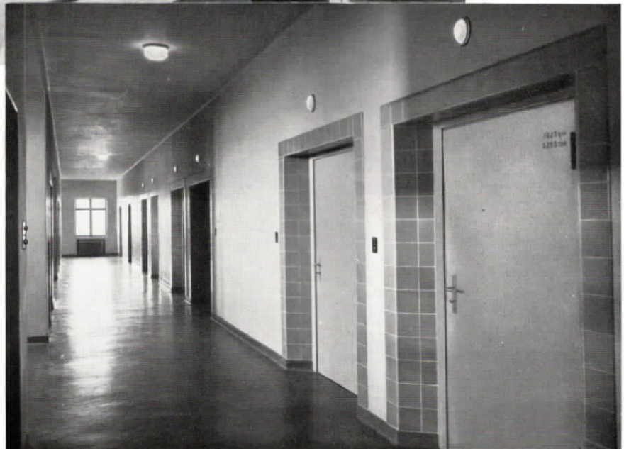
Abb. 95 (Mitte). Krankenzimmer mit Fuld-Fernsprecher, Birntaster für den Lichtruf und kombiniertem Ruf- und Abstelltaster mit Beruhigungslampe (links von der Tür) im Mütter- und Säuglingsheim in Neukirchen im Rheinland.
