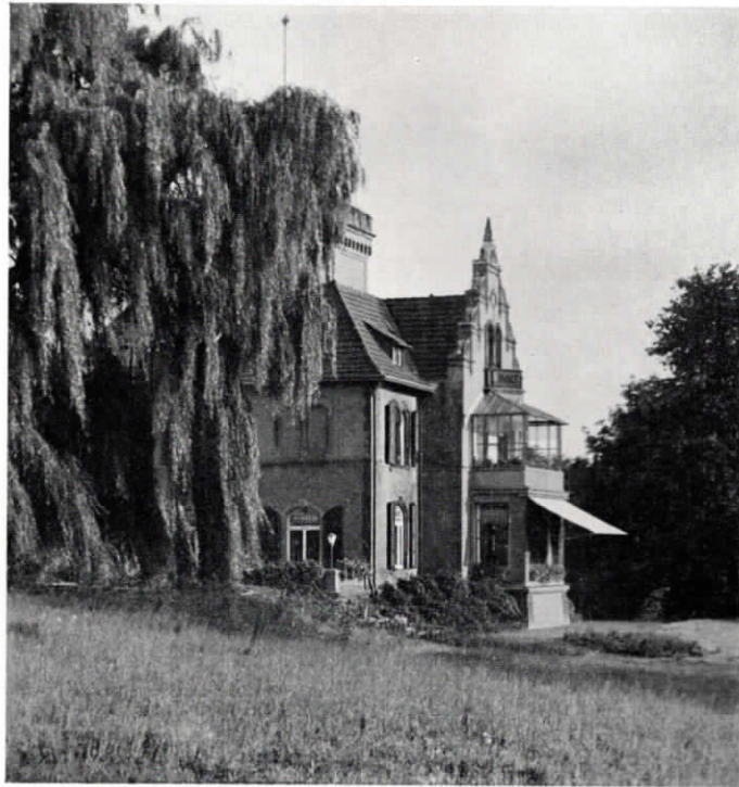
Abb. 62. Villa bei Erkrath mit einer Fuld-Fernsprech-, Lichtsignal- und elektrischen Uhrenanlage ausgestattet.
