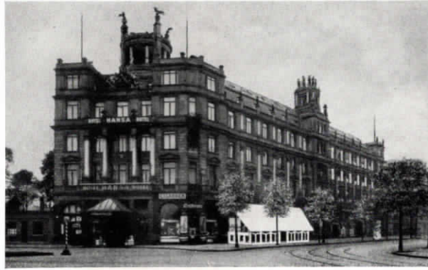
Abb. 45. Das Hansa-Hotel in Düsseldorf besitzt eine Fuld-Fernsprechanlage, bestehend aus einer Glühlampenzentrale für 4 Amtsleitungen und 60 Nebenstellen und 60 Apparaten für Amtsgespräche.
