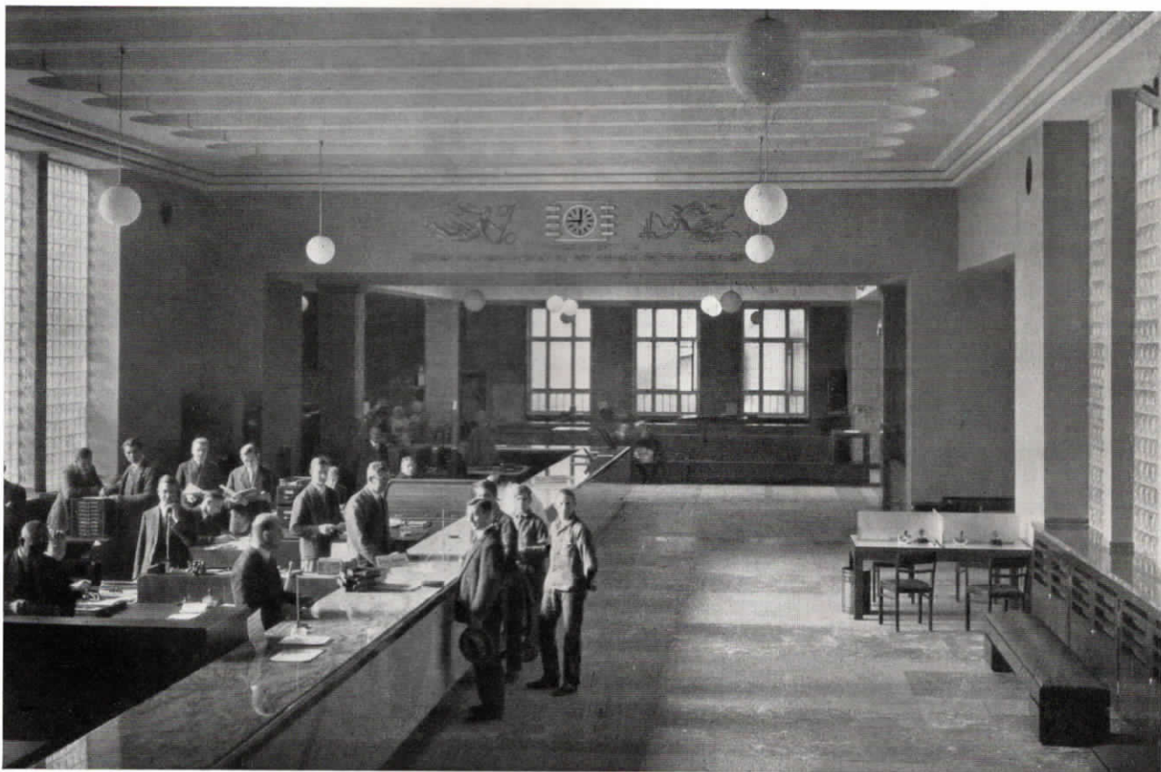
Abb. 7. Schalterraum in der Kreissparkasse mit Fuld-Fernsprechapparaten und Normalzeit-Nebenuhr.
