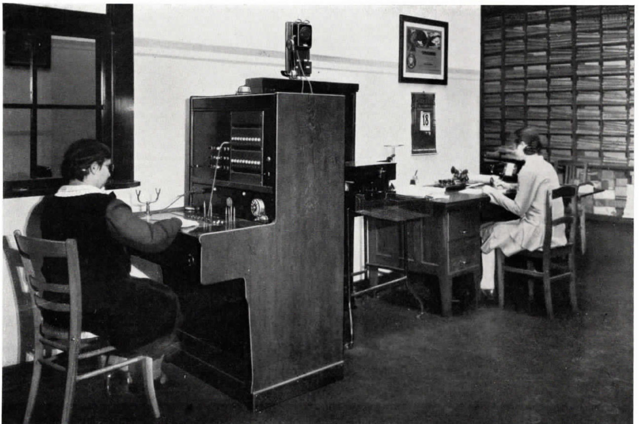
Abb. 52. Fuld-Glühlampenzentrale, Spezialkonstruktion für Bedienung durch eine Blinde, bei Gebr. Aschaffenburg, Abteilung der Toga, Vereinigte Webereien A. G. in Gladbach-Rheydt.
