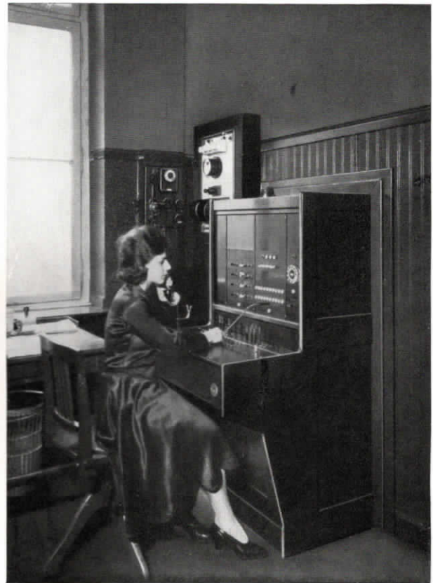
Abb. 34. Die Hugo Braunstein A. G. in Düsseldorf besitzt eine Fuld-Fernsprechanlage, bestehend aus einer Glühlampenzentrale für 4 Amtsleitungen und 20 Nebenstellen, eine vollautomatische Fernsprechanlage für 25 Teilnehmer für den internen Verkehr, ferner eine Personen-Lichtrufanlage.
