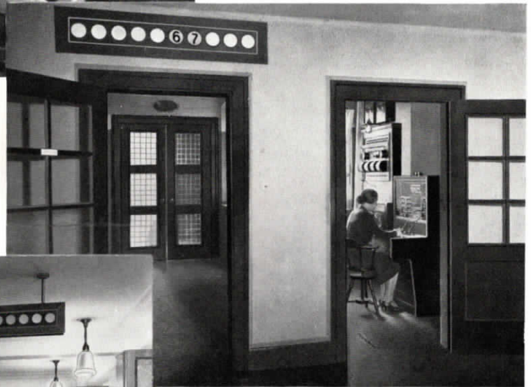
Abb. 26 (Mitte rechts). Blick in die Telefonzentrale mit Fuld-Glühlampenschrank für 4 Amtsleitungen und 20 Nebenstellen, ferner Schalttafel; links über der Tür in die Wand eingelassenes 10teiliges Lichtrufabla.
