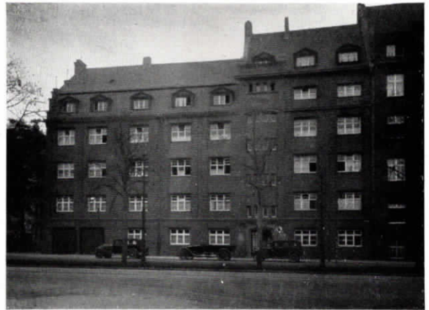
Abb. 43. Die Firma Klestadt & Stern in Düsseldorf verfügt über eine Fuld-Fernsprechanlage, bestehend aus einer Glühlampenzentrale für 10 Amtsleitungen und 40 Nebenstellen, einem Vorschaltapparat und 21 Post-Hausapparaten.
