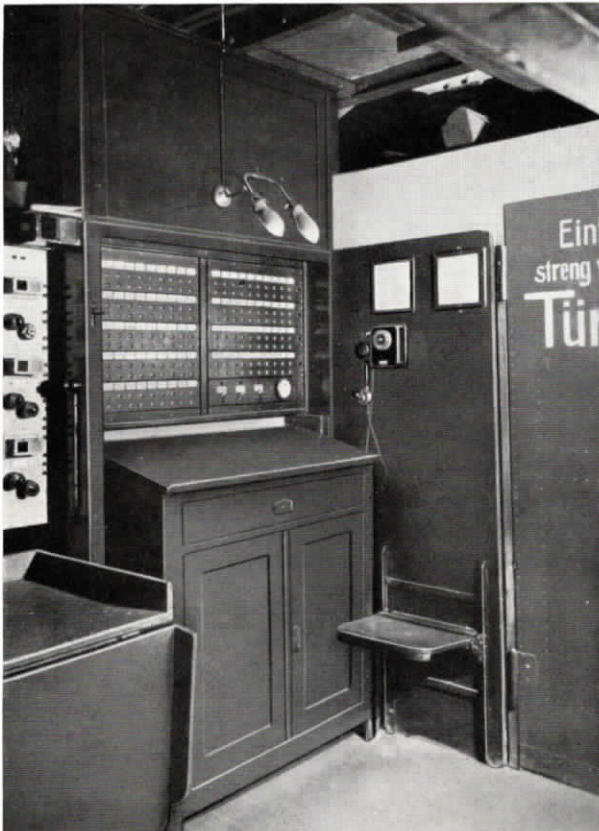
Abb. 86. Lichtruf-Schalttafel für etwa 60 Rufe im Stadttheater in Duisburg. Ferner verfügt das Stadttheater über eine Weckeranlage für das Bühnen- und Zuschauerhaus sowie über eine Feuermelde-Einrichtung.
