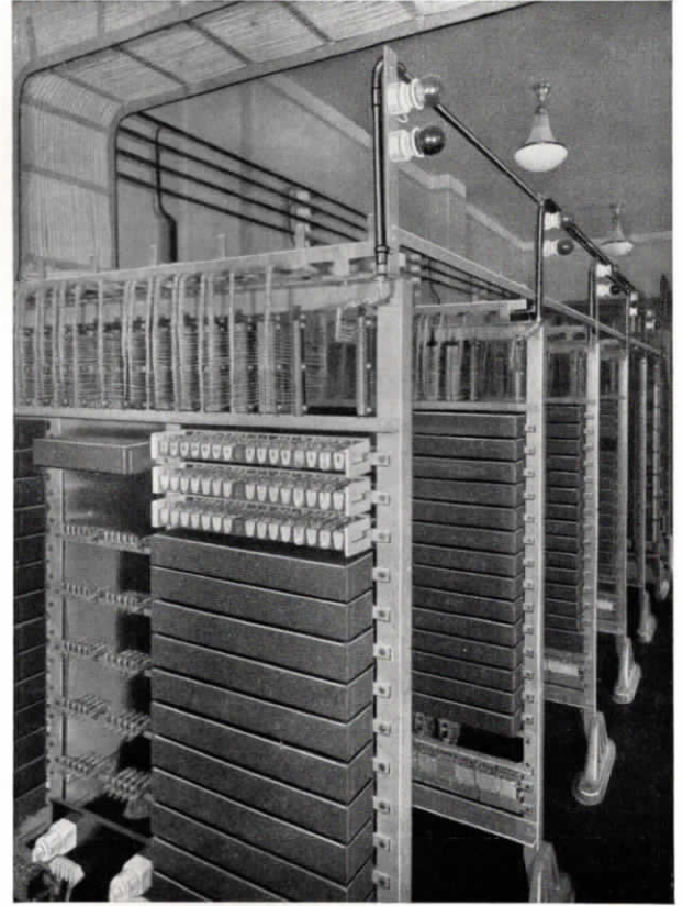
Abb. 13 und 14. Wähler- und Relaisgestelle der halbautomatischen Fuld-Fernsprechzentrale im Verwaltungsgebäude der Vereinigten Stahlwerke A. G., Düsseldorf.
