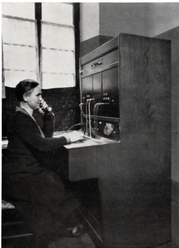
Abb. 2 und 3. Das Wohlfahrtsamt in Worms verfügt über eine halbautomatische Fuld-Fernsprechzentrale über fünf Amtsleitungen, 20 Nebenstellen und 4 Querverbindungen; dem internen Verkehr dient eine vollautomatische Fuld-Hauszentrale für 25 Teilnehmer.
