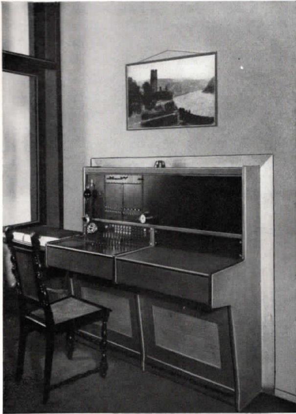
Abb. 21. Fuld-Fernsprech-Vermittlungsschrank (erweiterungsfähig) für 6 Amtsleitungen und 30 Nebenstellen, sowie 5 bevorzugte Direktions-Nebenstellen. Die Abb. 21 und 22 sind in der Hanco Industrie- und Handelsgesellschaft Coblenz am Rhein aufgenommen.
