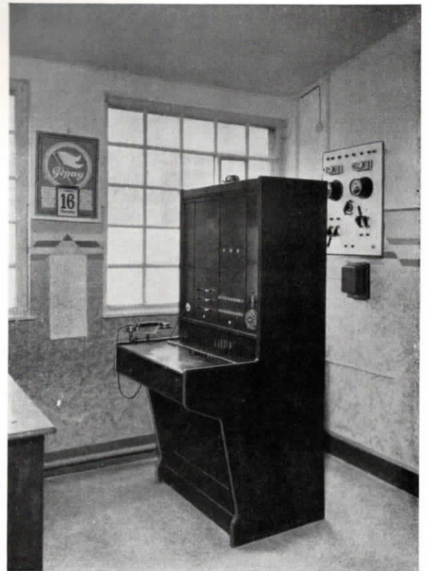
Abb. 16. Fuld-Fernsprech-Glühlampenzentrale für drei Amtsleitungen, 20 Nebenstellen und 3 Querverbindungen; dem internen Verkehr dient eine vollautomatische Fuld-Hauszentrale für 25 Teilnehmer.
