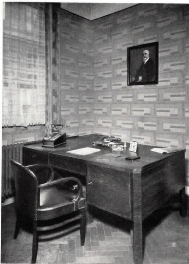
Abb. 73. Direktionszimmer mit Fuld-Fernsprech-Vorschaltapparat im Warenhaus Tietz A. G. in Krefeld. Die Fernmeldeanlage besteht aus einer Glühlampenzentrale, einer automatischen Fernsprechzentrale für 50 Teilnehmer, einer Feuermeldeanlage und einer elektrischen Uhrenanlage mit Ringsignal.
