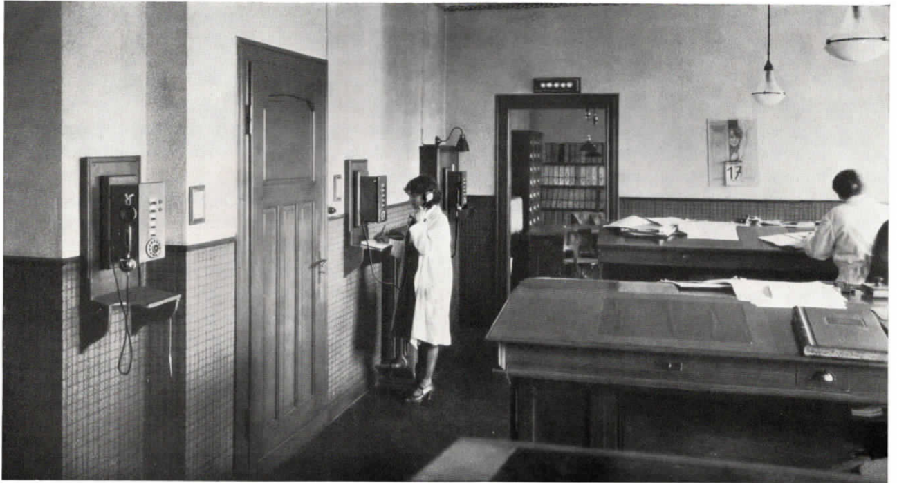
Abb. 31. Die Rheinische Zuckerwarenfabrik G. m. b. H., Düsseldorf besitzt eine Fuld-Fernsprech-Reihenanlage für 2 Amtsleitungen, 7 Nebenstellenapparate und 12 Hausapparate, ferner eine vollautomatische Fuld-Fernsprechzentrale für den internen Verkehr für 25 Teilnehmer, außerdem eine Lichtruf-Anruf-Einrichtung (Spezialausführung).
