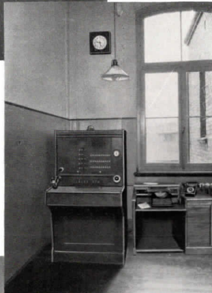
Abb. 88 (oben). Die Fernsprechanlage der Allgemeinen Speditionsgesellschaft A. G. in Duisburg besteht aus einer halbautomatischen Fuld-Zentrale für 11 Amtsleitungen und 34 Nebenstellen; dem internen Verkehr dient eine vollautomatische Hauszentrale für 50 Teilnehmer.
