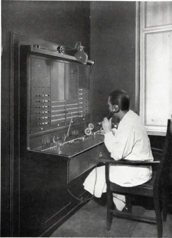
Abb. 8. Fuld-Glühlampenzentrale für 12 Amtsleitungen und 90 Nebenstellen beim Kreisausschuß des Landkreises Düsseldorf. Dem internen Verkehr dient eine vollautomatische Fuld-Fernsprechzentrale für 100 Teilnehmer.
