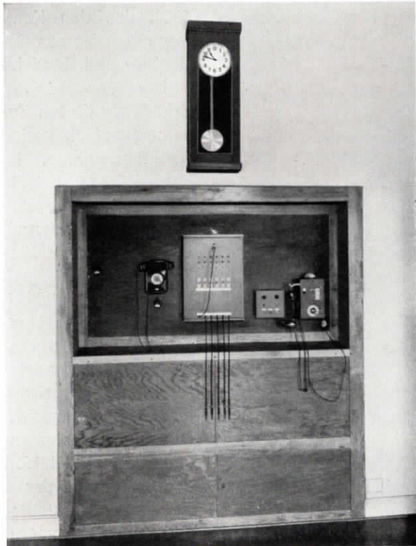
Abb. 64. Fuld-Fernsprechzentrale und Normalzeit-Hauptuhr in einer Villa bei Erkrath. Diese Anlage umfaßt 6 Reihenapparate für eine Amtsleitung, einen Vermittlungsschrank für eine Amtsleitung und 6 Nebenstellen sowie eine vollautomatische Hauszentrale für 10 Teilnehmer.
