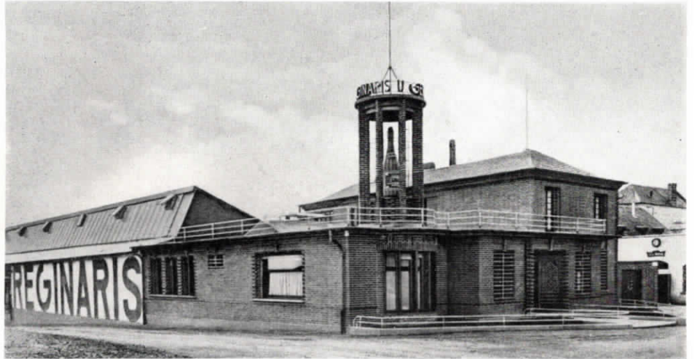
Abb. 5. Der Reginaris- und Genoveva-Brunnen in Niedermendig am Laacher See besitzt eine Fuld-Fernsprech-Reihenanlage für 2 Amtsleitungen in Verbindung mit einer vollautomatischen Fuld-Hauszentrale für 10 Teilnehmer.
