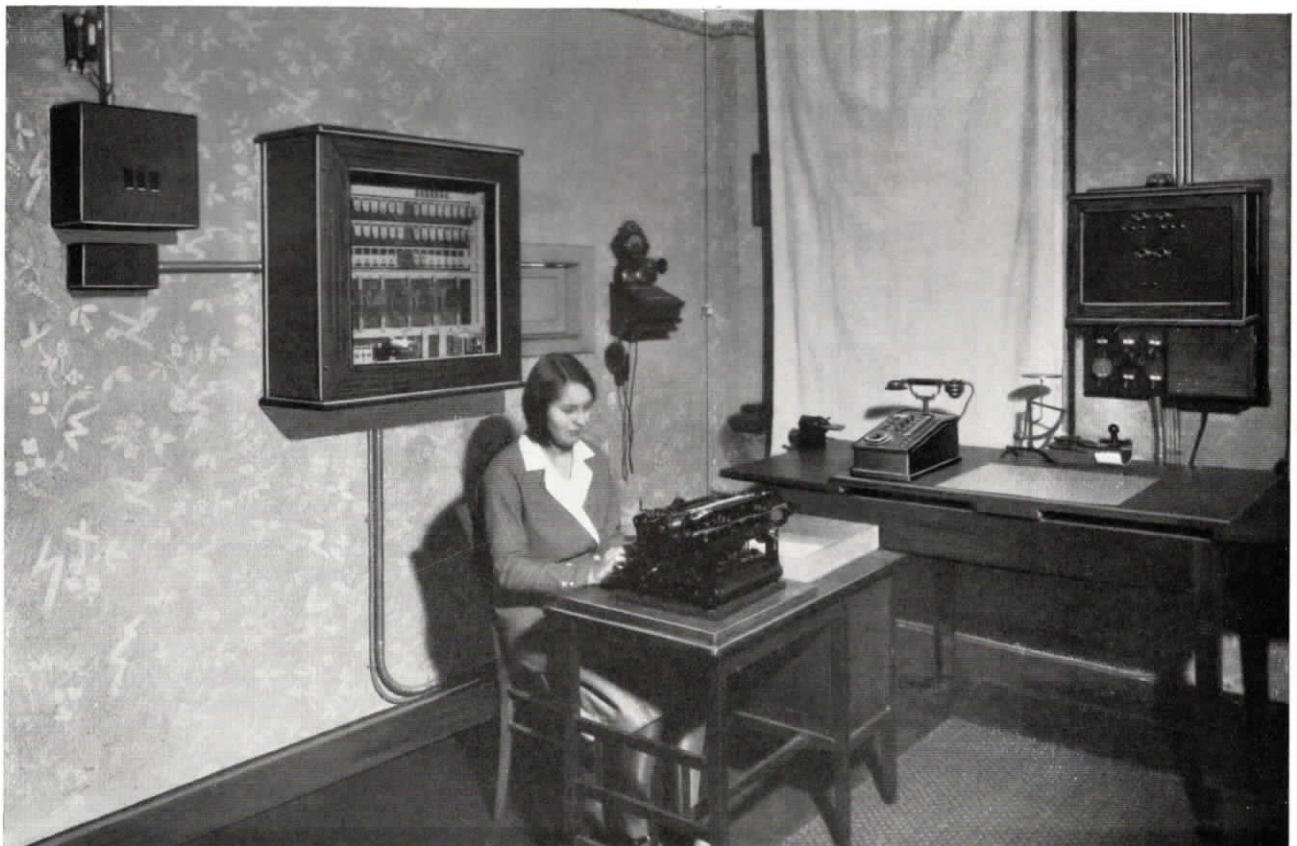
Abb. 84. Fuld-Fernsprechzentrale im Rathaus Kempen. Die Fernmeldeanlage besteht aus einer Fuld-Reihenanlage für 2 Amtsleitungen, einem Umschaltschrank für 3 außenliegende Nebenstellen zur Wohnung des Bürgermeisters, der Polizei und der Sparkasse. Dem internen Verkehr dient eine vollautomatische Zentrale für 23 Teilnehmer.
