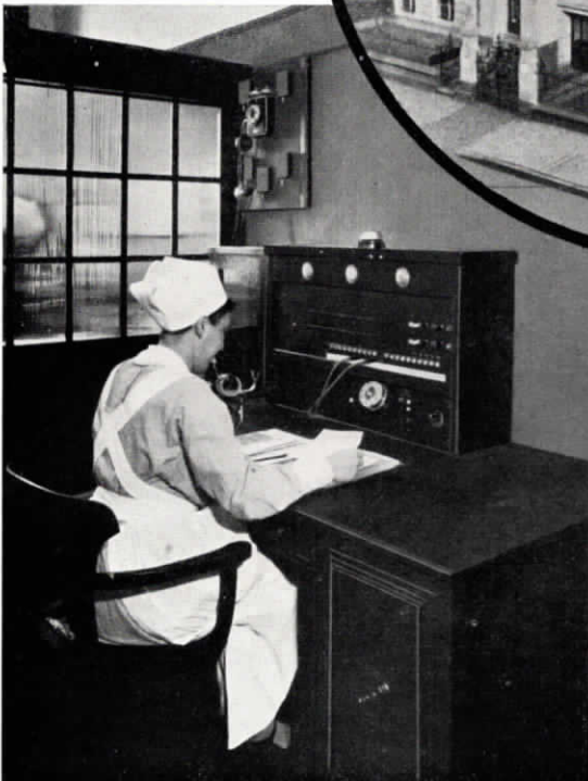
Abb. 60. Fuld-Glühlampenzentrale für 2 Amtsleitungen und 20 Nebenstellen mit selbsttätiger Trennung, im Luisen-Krankenhaus in Düsseldorf.
