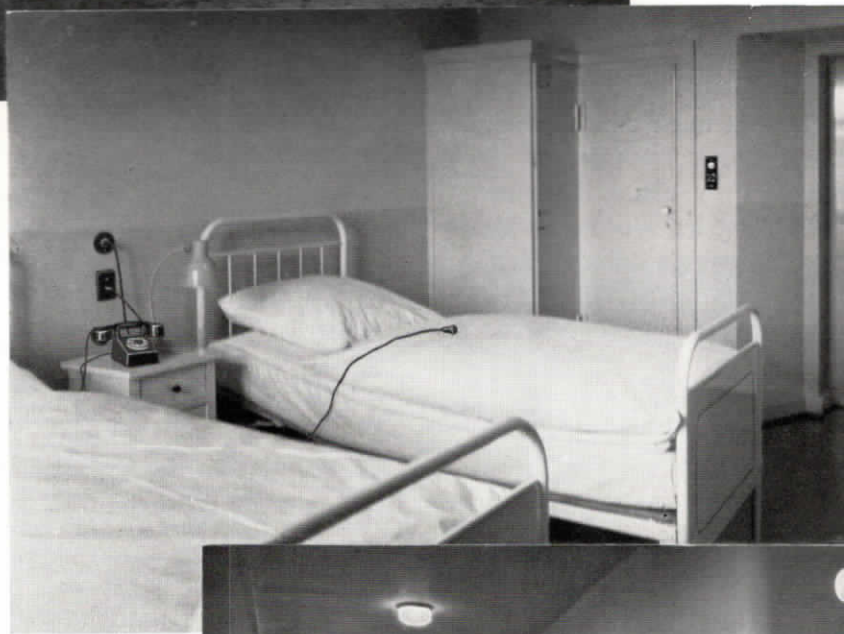
Abb. 94 (oben). Das Mütter- und Säuglingsheim in Neukirchen im Rheinld. verfügt über eine Fuld-Reihenanlage für eine Amtsleitung und eine automatische Fuld-Zentrale für den Hausverkehr, ferner über eine ausgedehnte Lichtsignalanlage.
