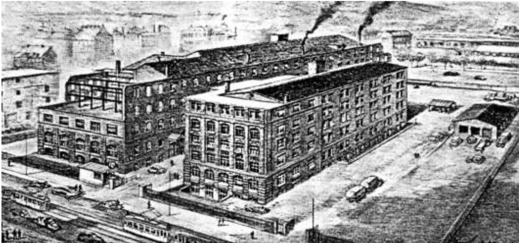
Ansicht des Werkes 1 Mainzer Landstr. 134-142 z. Zt. des Wiederaufbaues im Jahre 1949
