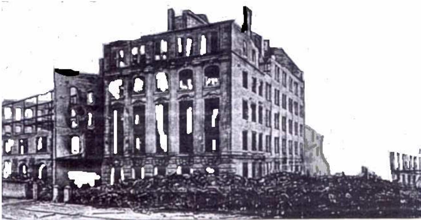
Die Reste der TN in der Mainzerlandstrasse.
