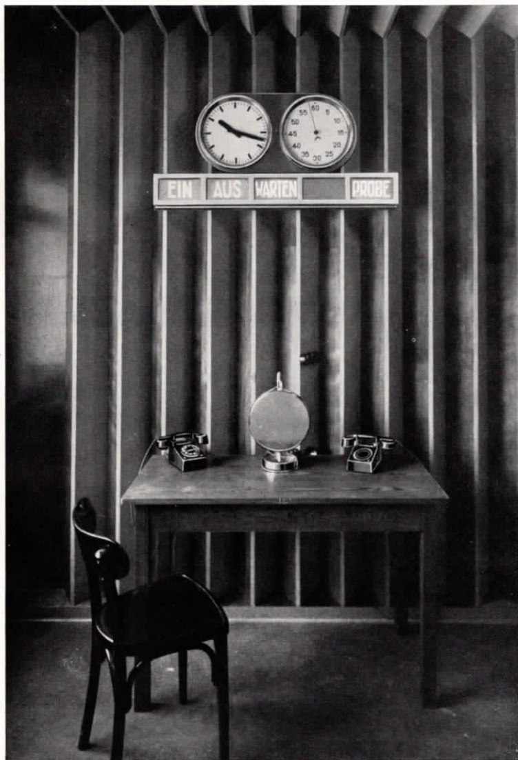
Abb. 4. Signaltablo, elektrische Uhren, Gong, Telefonapparate für Post- und Hausverkehr und Betriebstelefon im Sprecherraum des Reichssenders Königsberg i. Pr.
