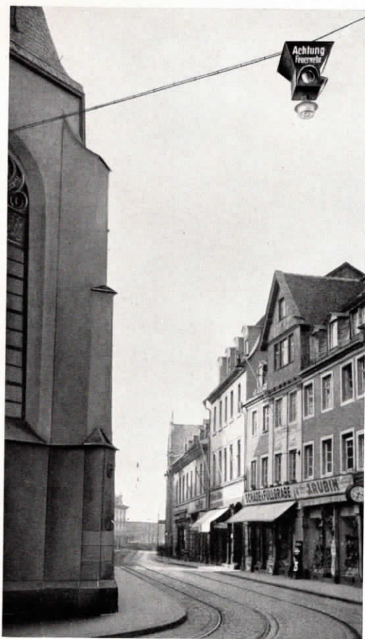
Abb. 5. Verkehrslampe mit Straßen-Beleuchtung.
