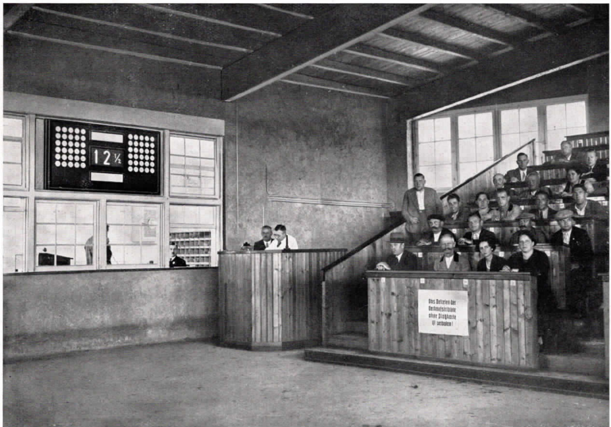
Abb. 1 Verkaufshalle mit der neuen elektrischen T. u. N.-Verkaufsanlage in der Bezirksabgabestelle für gartenbauliche Erzeugnisse in Bühl (Baden).
