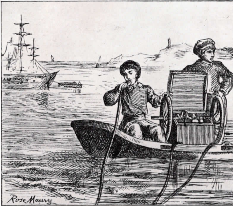
Abb. 116. Das erste Telephon für Taucher, ausgeführt von Direktor Dohrn in der Fischereistation zu Neapel (1880)
