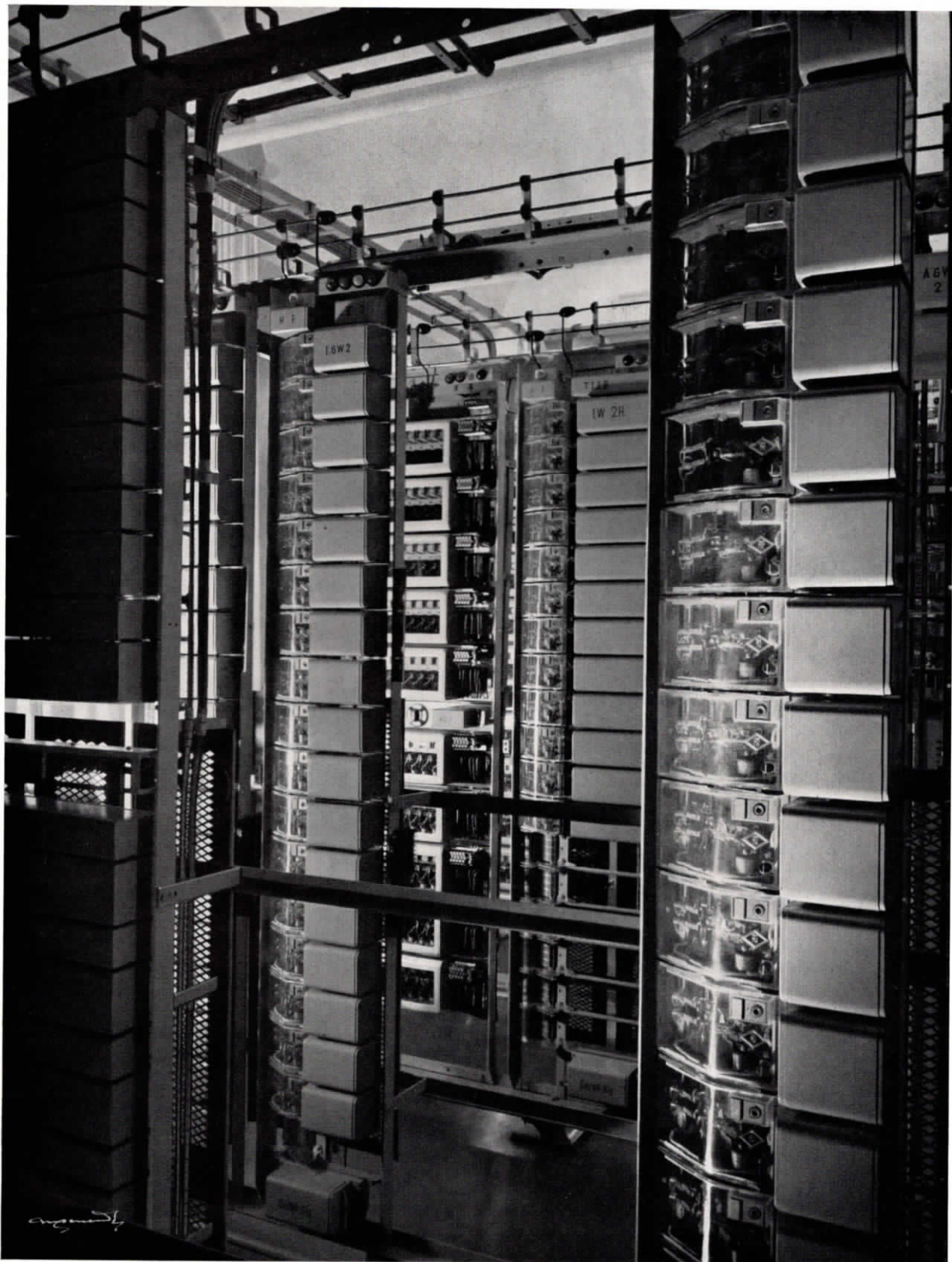
Abb. 5 Einen Blick auf die Wählergestelle
