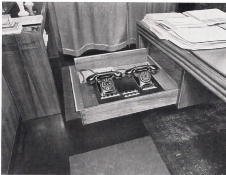
Abb. 4 In den Schreibtisch eingebaute Chef- und Sekretär-Fernsprechanlage „Pikkolo“ im Arbeitszimmer des Herrn Präsidenten
