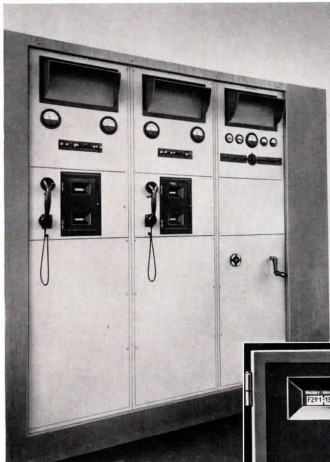
Abb. 17 Feuermelde-Anlage nach dem Universalsystem der TuN
