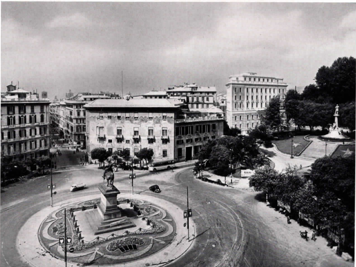
Abb. 1 Die Provinzverwaltung in Genua hat seit 1878 ihren Sitz in dem Palazzo Spinola, den Antonio D'Oria nach Zeichnungen des Mönches Giovanni Angelo Montorsoli um die Mitte des 16. Jahrhunderts errichten ließ. Ein Erweiterungsbau (rechts) wurde 1953 eingeweiht
