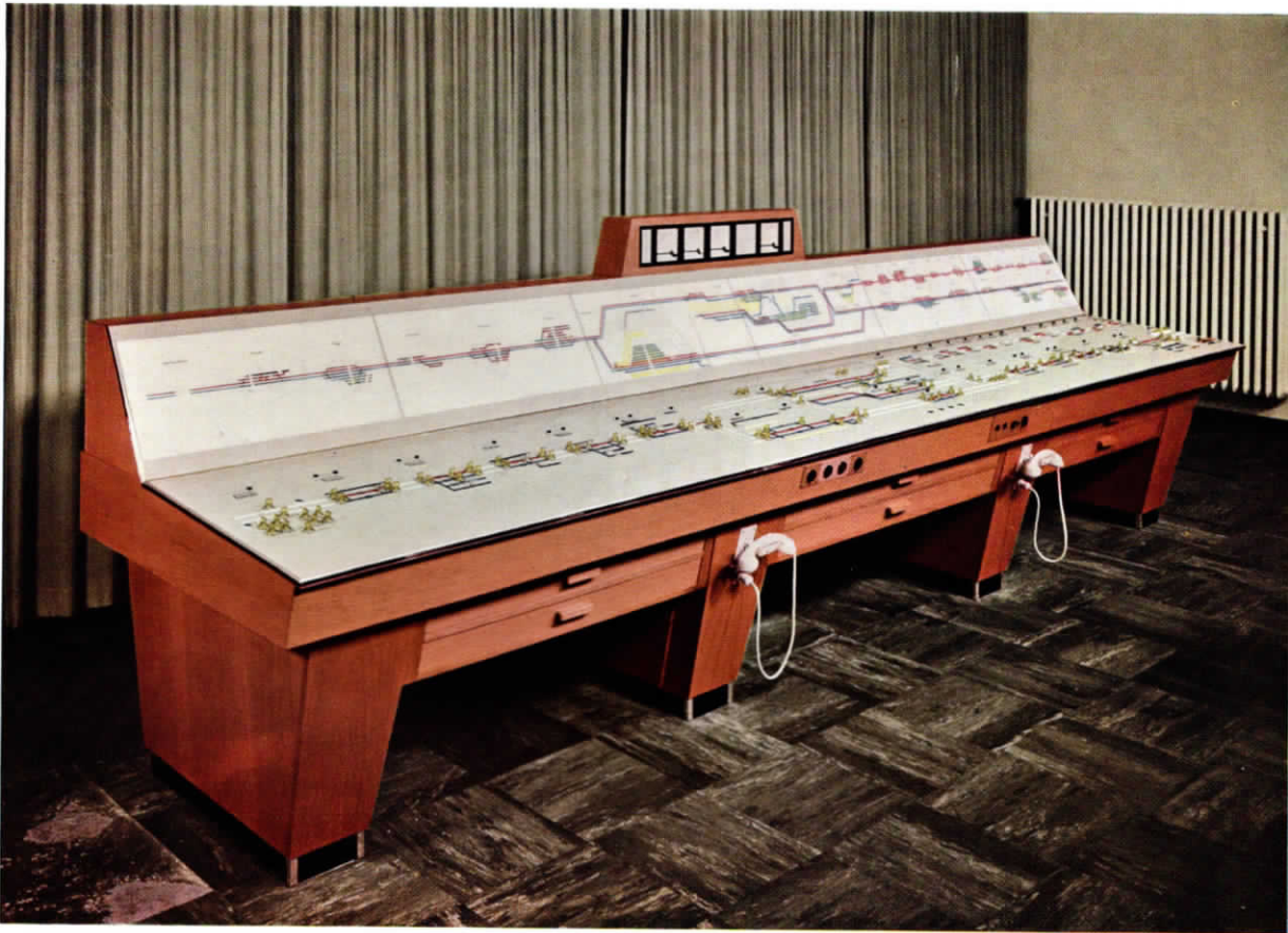
Bild 1 Bedienungspult mit Streckenleuchtbild für den Bereich des UW-Freiburg der Bundesbahndirektion Karlsruhe
