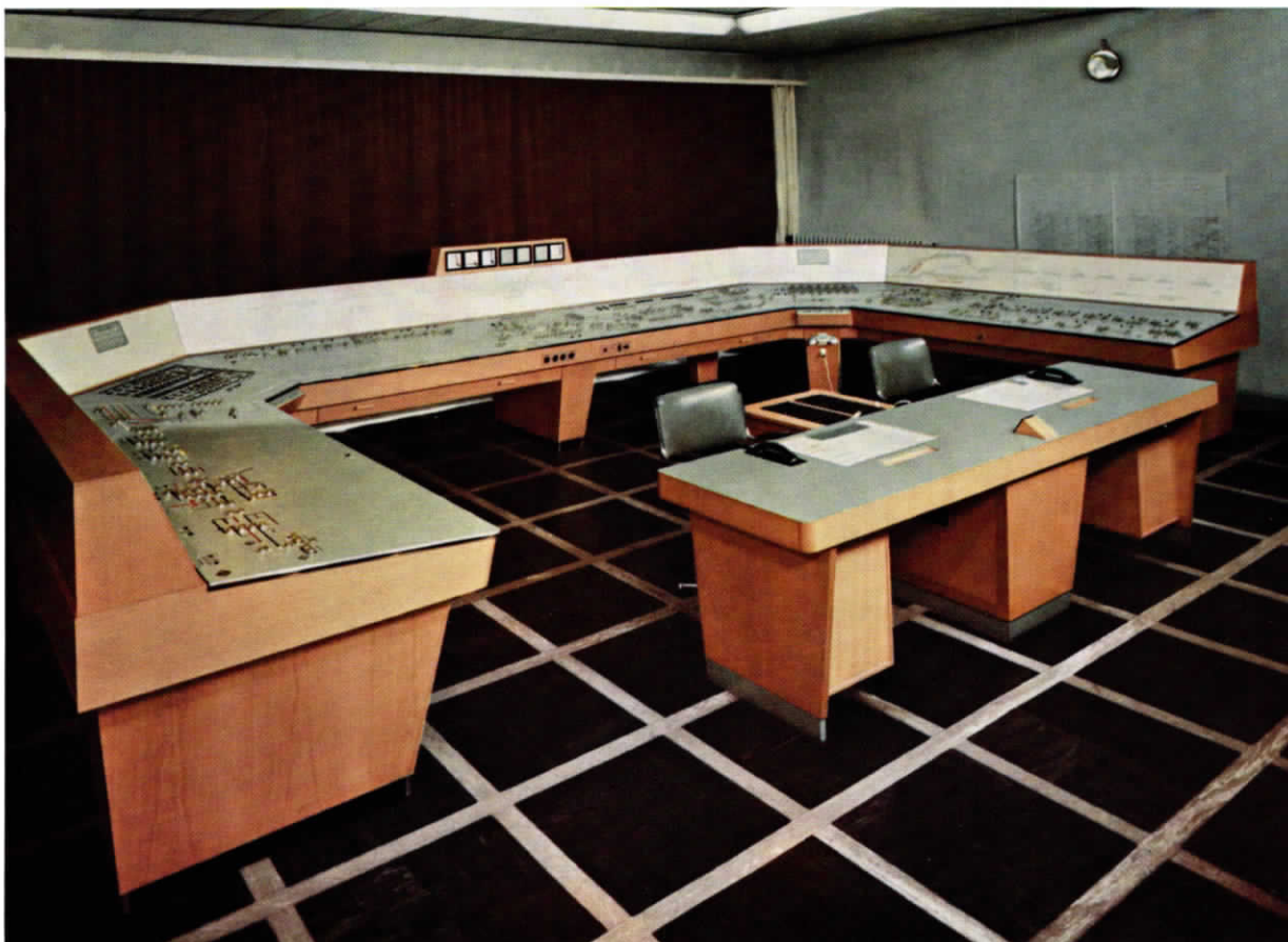
Die z. Z. größte im Betrieb befindliche Fernwirkanlage der Deutschen Bundesbahn – Unterwerk Mannheim/Friedrichsfeld, Bundesbahndirektion Karlsruhe –
