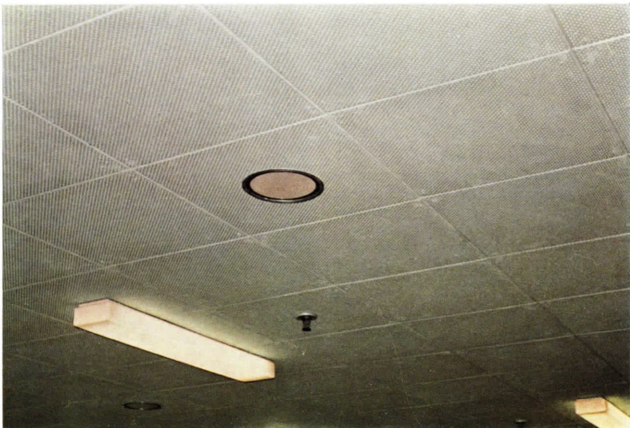
Eingebauter Deckenlautsprecher
