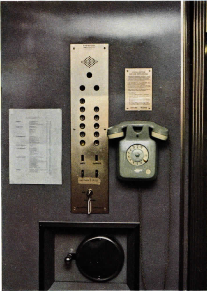
BILD 3 Fernsprechapparat im Aufzug
