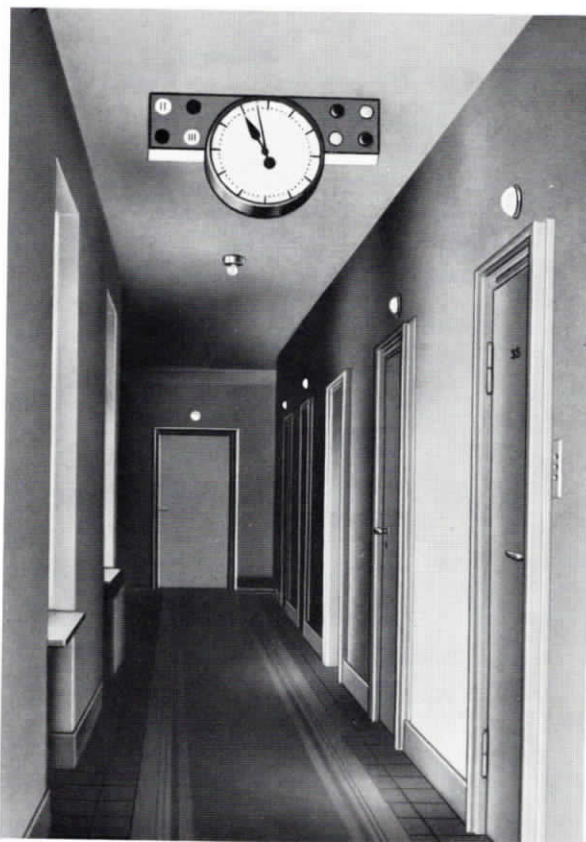
BILD 7 Lichtruf-Anlage in einem Krankenhaus
