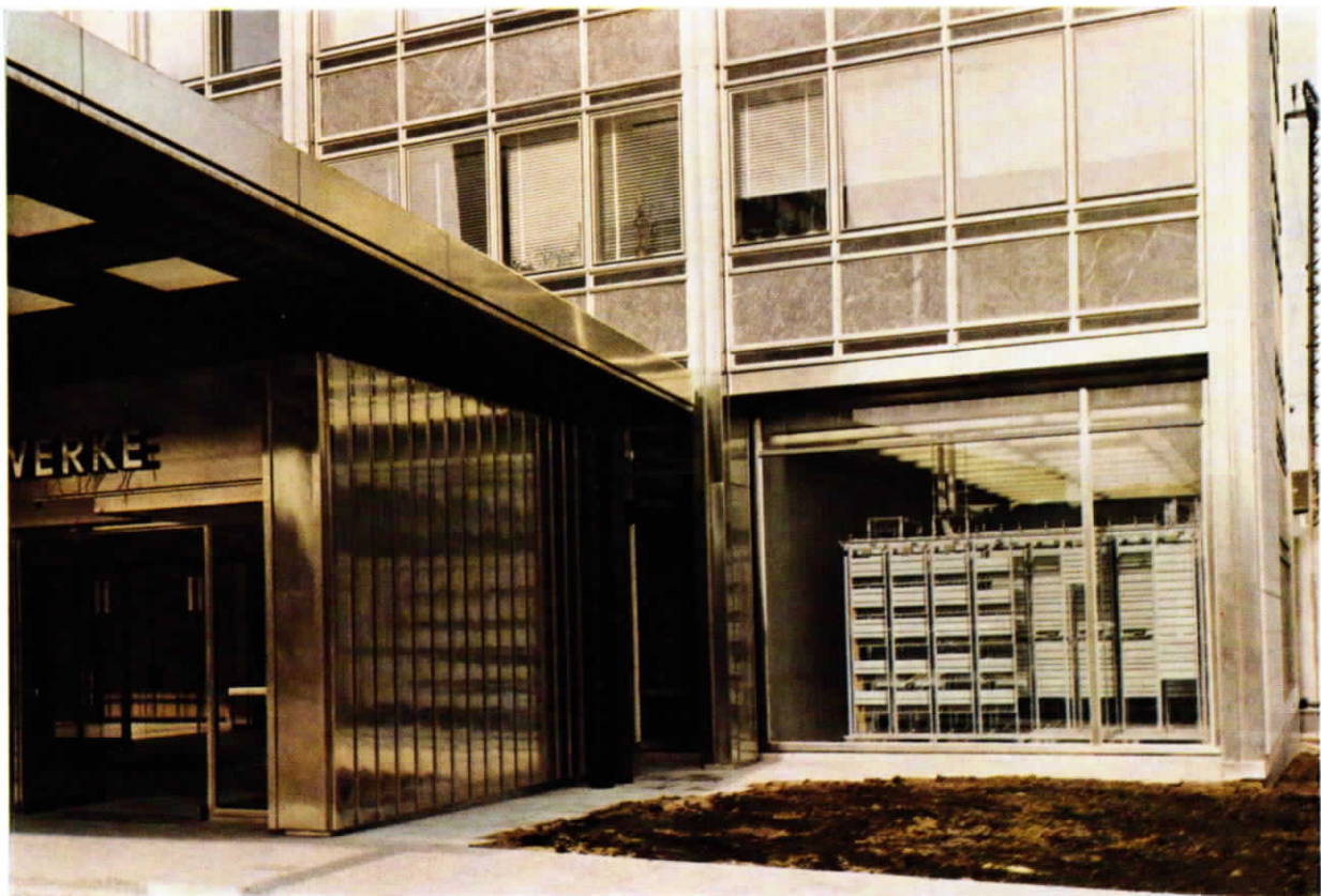
BILD 3 Außenansicht des Wählersaales
