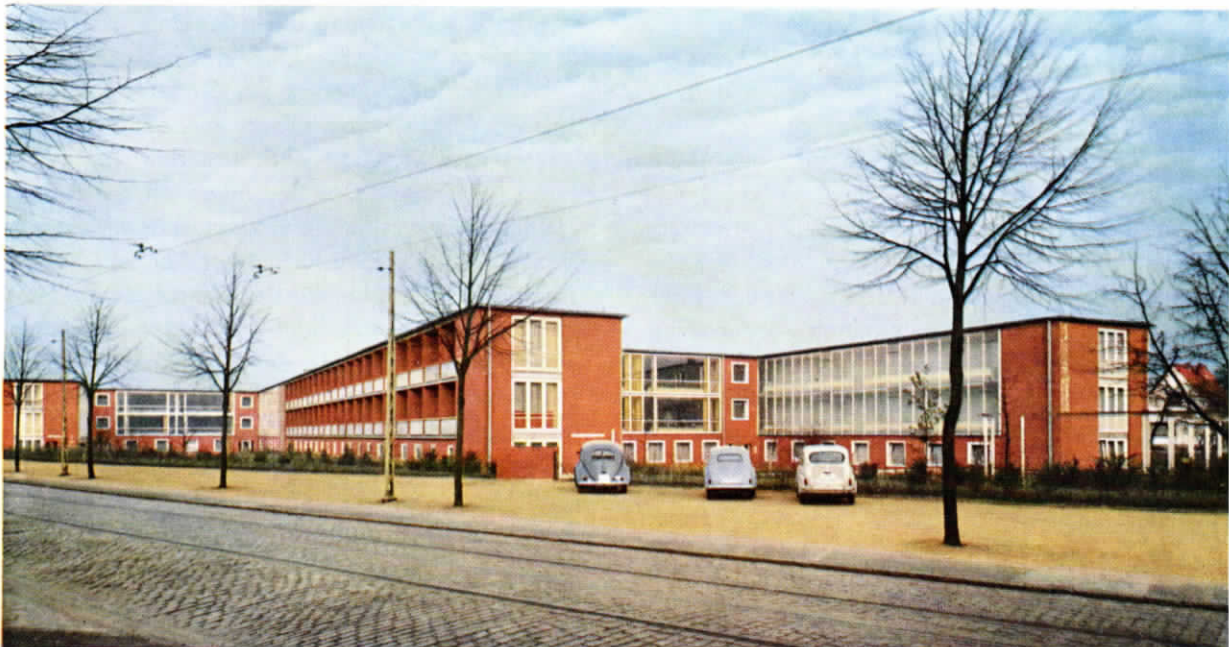
BILD 1 Gesamtansicht des Studentenwohnheimes
