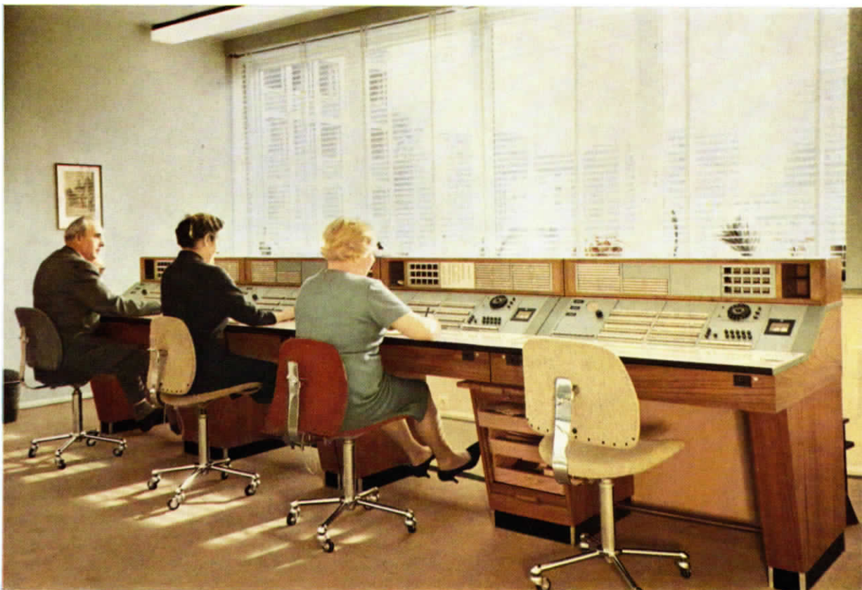
BILD 2 Die vierplätzigc Vermittlungseinrichtung
