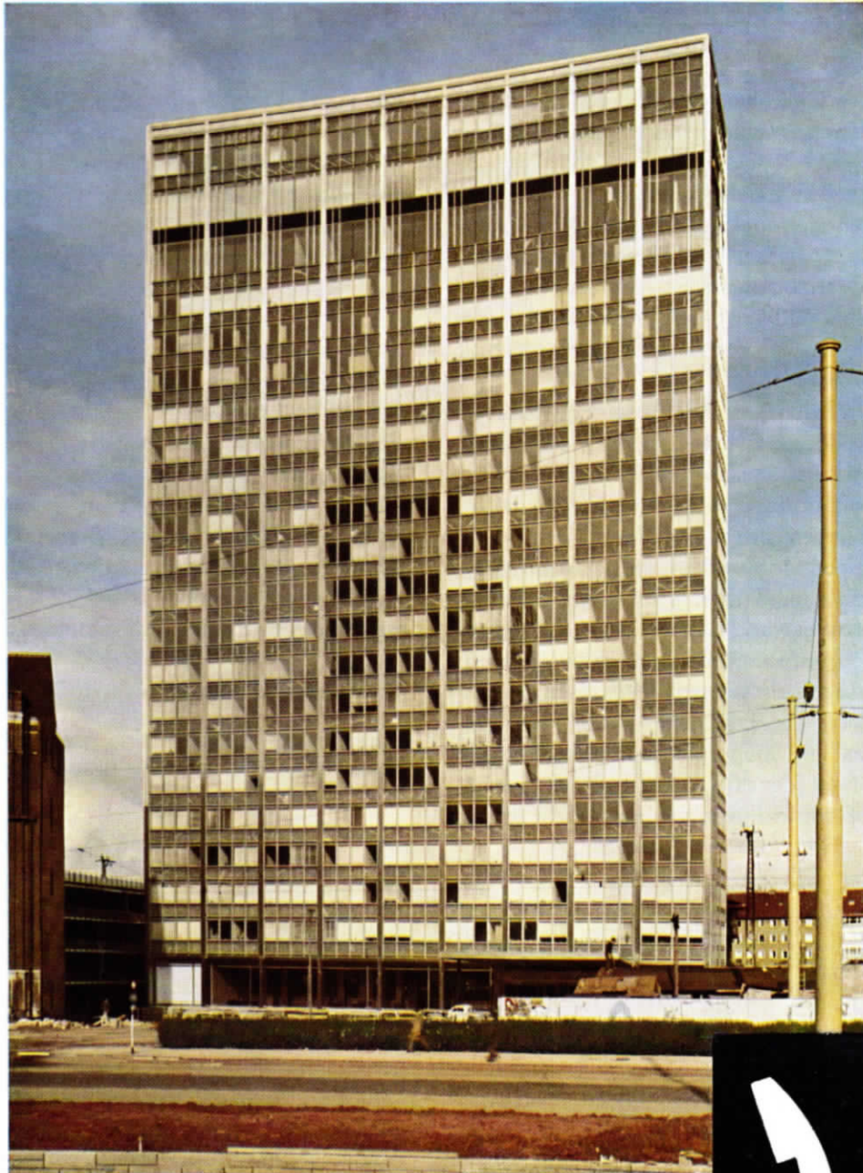
BILD 1 Das neue Rheinstahl-Hochhaus
