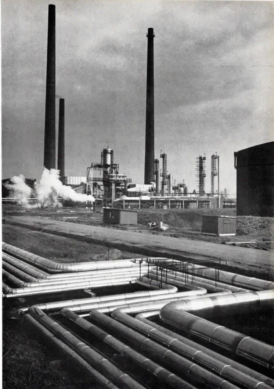
BILD 1 Die Erdölwerke Frisia
