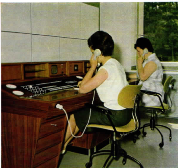
BILD 11 Vermittlungsplätze für die Nebenstellenanlage
