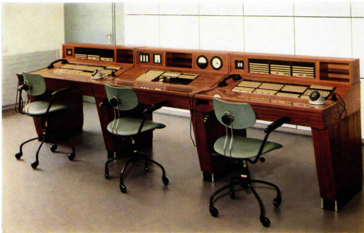
BILD 2 Bedienungsplätze der Sicherheitszentrale
