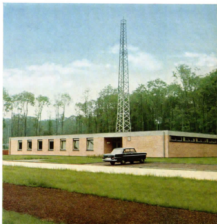
BILD 7 Antennenmast für die Sprechfunkanlage
