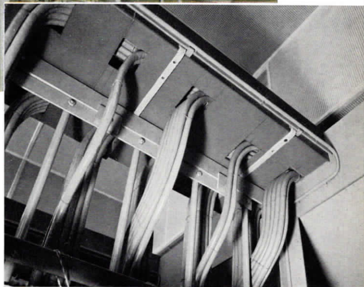
BILD 5 Detailaufnahme der Kabelführung
