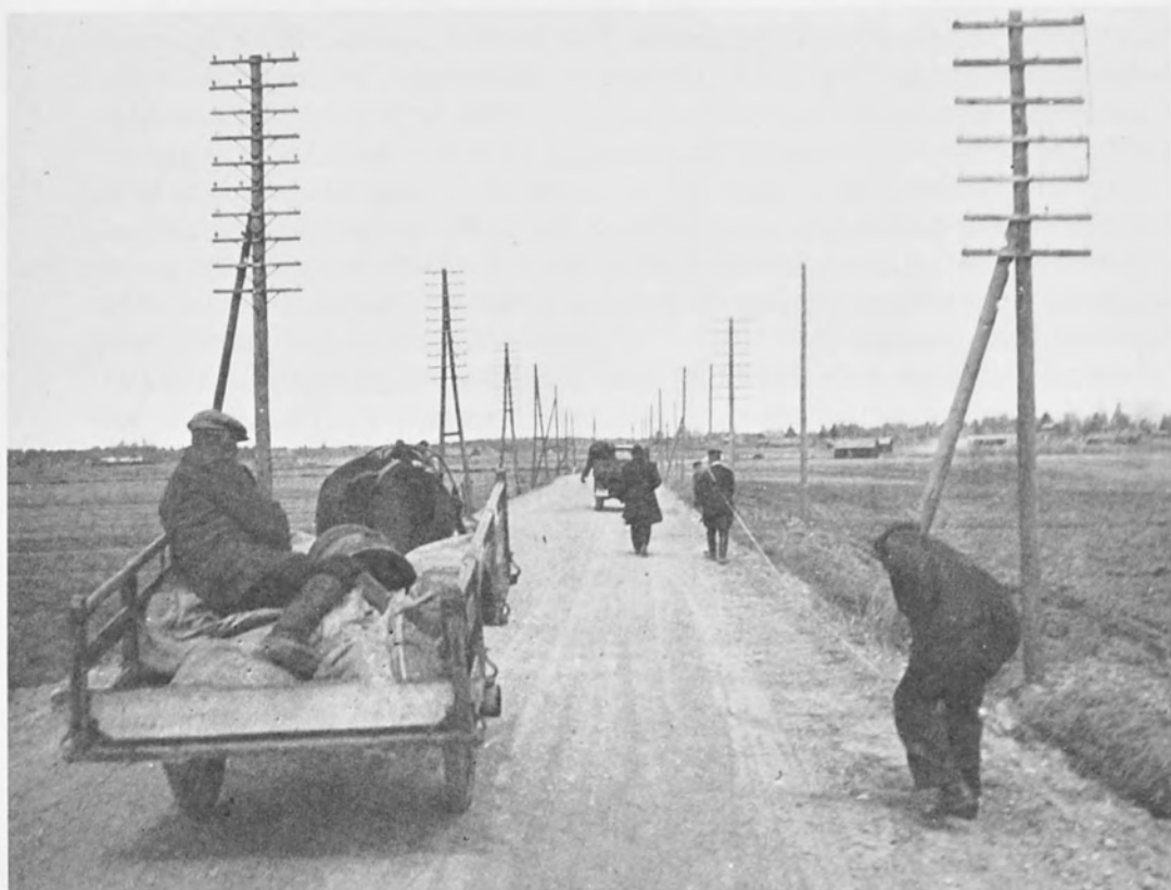
Asemaosaston päällikkö John Rosberg (yllä oik.) oli Helsingin ja sen ympäristön automatisoinnin keskeisiä hahmoja; yllä vas. puhelinverkon kunnostus- ja automatisointitöitä 30-luvun alussa Malmilla ja alakuvassa Vantaalla.
