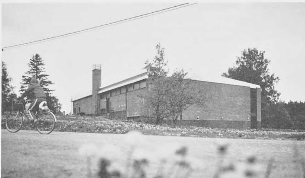
Vantaankosken puhelinkeskukseen on liitetty n. 7 300 vantaalaista puhelintilaajaa.
