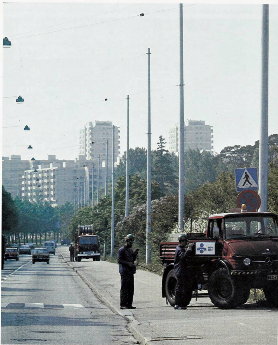
Tilaajakaapelia lasketaan kaapelikanavaan Mäkelänkadulla Helsingissä.
