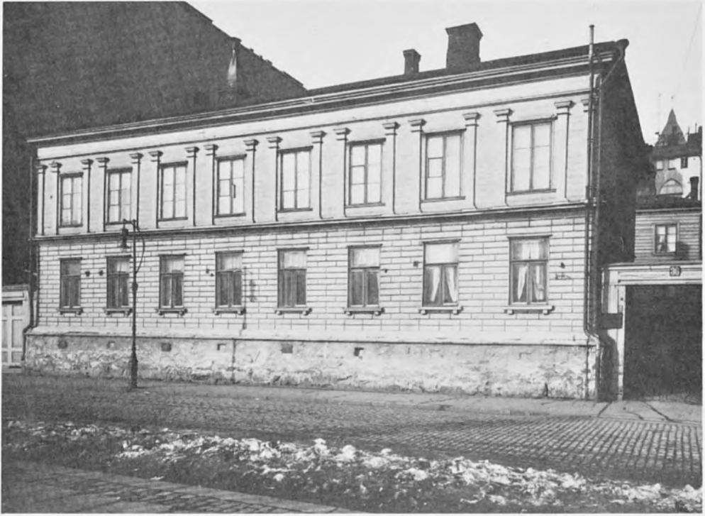
Kasarmikatu 36:n tontti, jonka Helsingin Puhelinyhdistys hankki 1908. Takana näkyy yhdistyksen päärakennusta Korkeavuorenkadulla.
