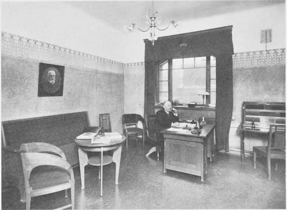
Toimitusjohtaja Fredrik Rosberg työhuoneessaan 1916.
