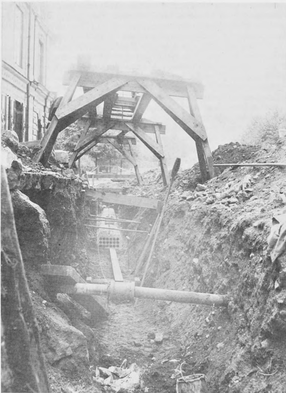
Kaapelikanavan rakennustyömaa Fabianinkadulla 1900-luvun alussa.
