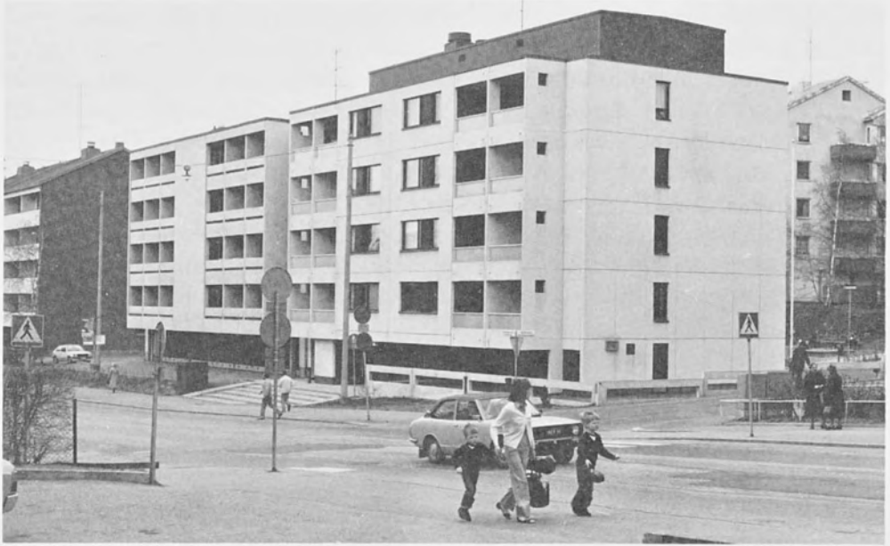
Helsingin Puhelinyhdistyksen 1978 valmistunut asuintalo Lauttasaarella. Rakennuksen kellaritiloissa on puhelinkekus.
