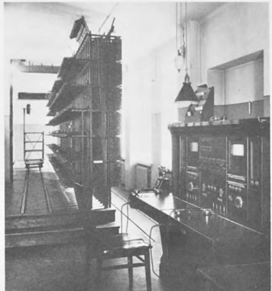
Töölön keskusrakennuksessa otettiin käyttöön Suomen ja Pohjoismaiden ensimmäinen automaattikeskus 1922; alla vas. keskuksen telinerivistöä, oik. ristikytkentähuone.
