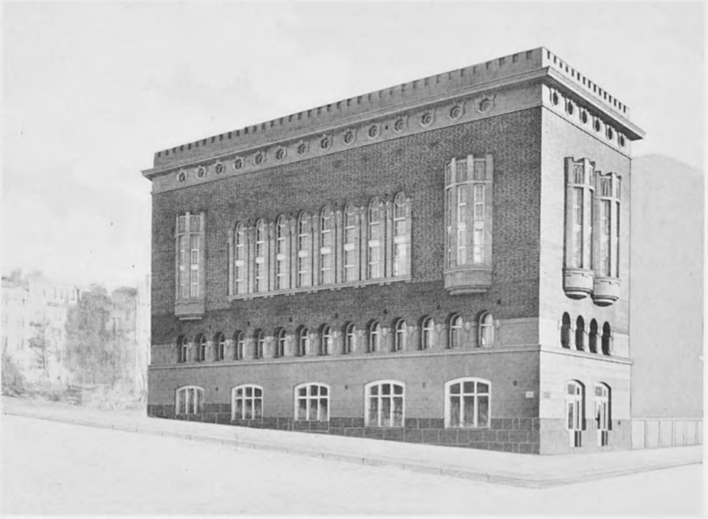
Töölön puhelinkeuhkus valmistui 1915; arkkitehti Lars Sonck.
