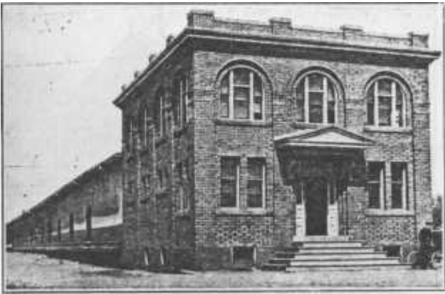
Freight Sheds, G. T. R.
