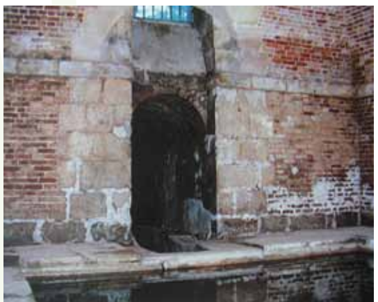
L'arrivée de l'aqueduc Henri IV au « château d'eau », en contrebas de la maison du fontainier, située au 22, rue du Château. Par un collecteur d'une longueur de 100 mètres environ, l'eau se déverse ensuite dans le Miroir où aboutit aussi l'aqueduc François I er . Photo Roseline Grimaldi-Hierholtz.
