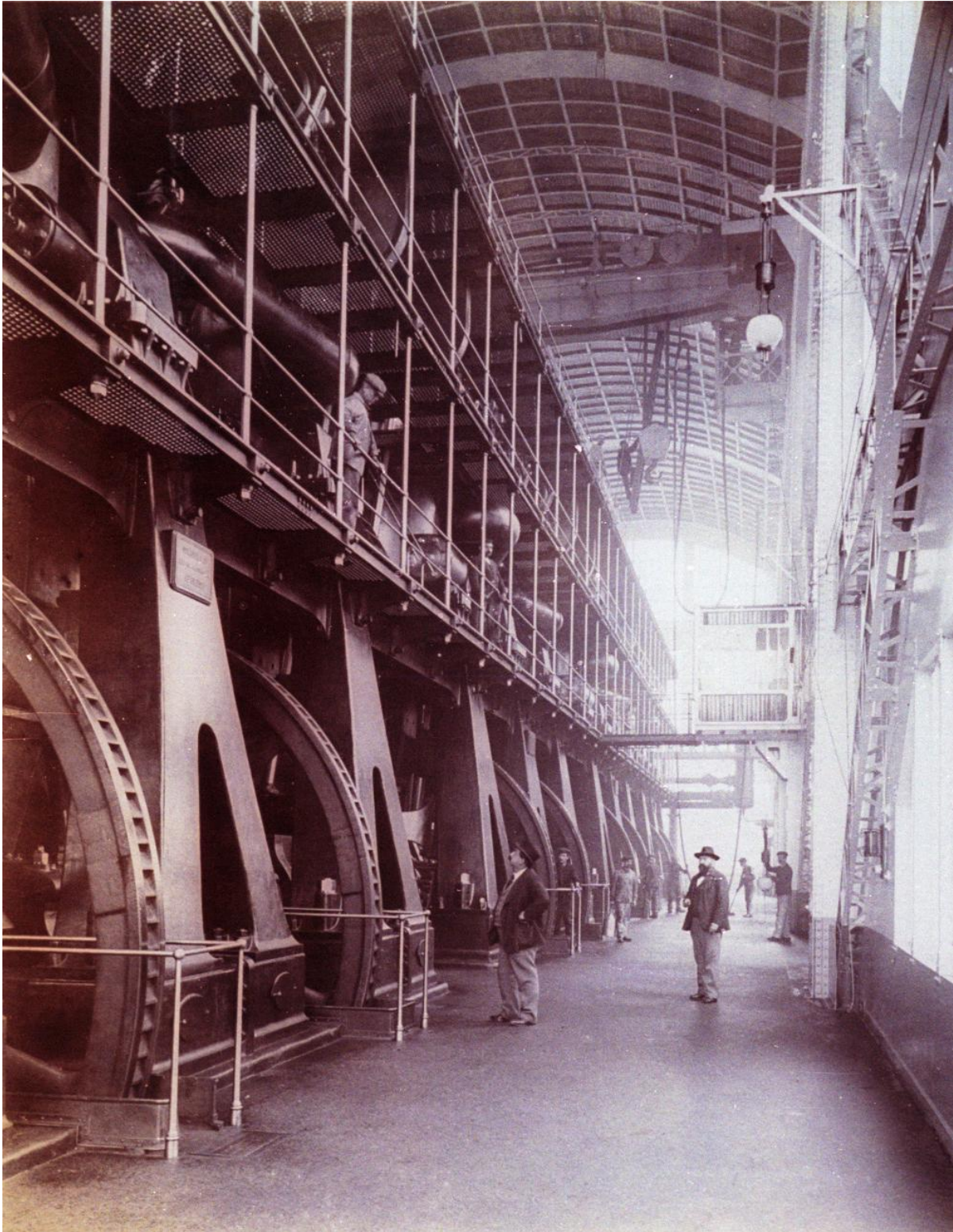
Salle des machines - Usine Quai de la Gare vers 1905 (1)
