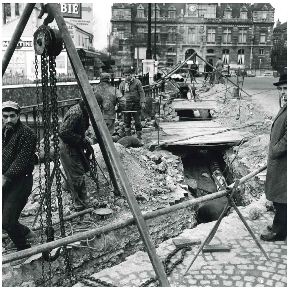
Travaux d'extension devant la Mairie de Pantin (1954)
