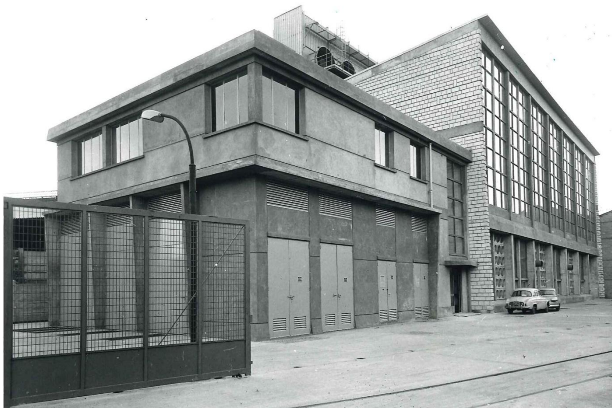
Vue générale de la centrale d'Aubervilliers
