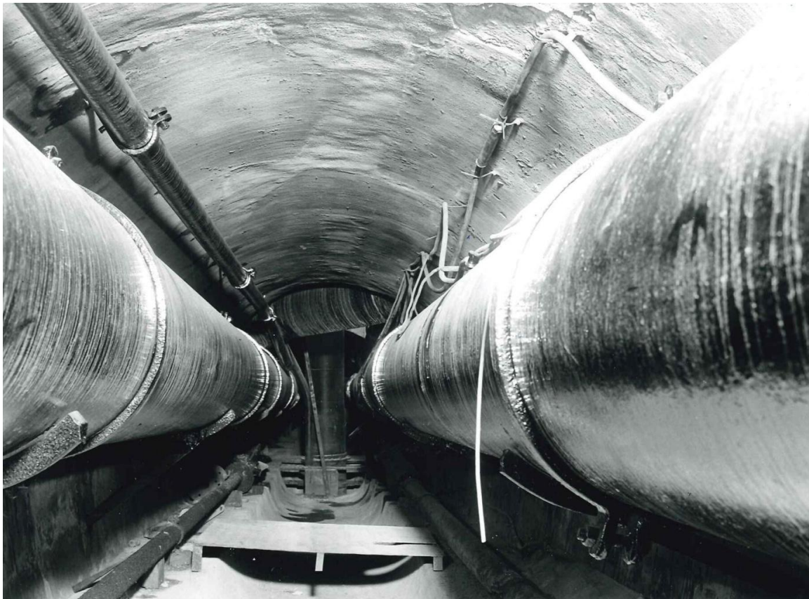
Canalisations d'air comprimé
