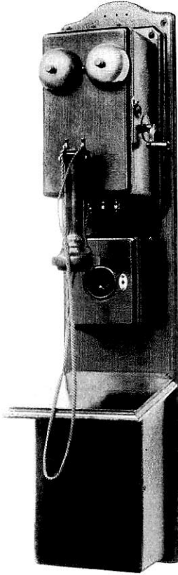
Fig. 2. Vägghäpparat av Bell-Blake typ använd i Stockholms Bell Telefonaktiebolags nät. Utländsk tillverkning från 1880 eller 1881.
